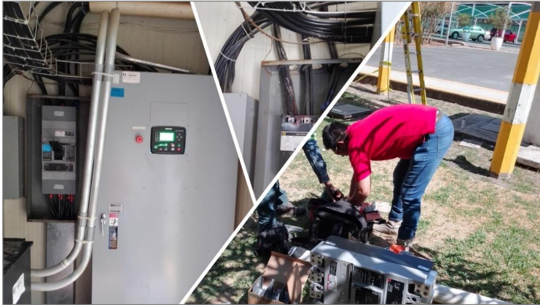
Ilustración 33. Cambio de acometida.
