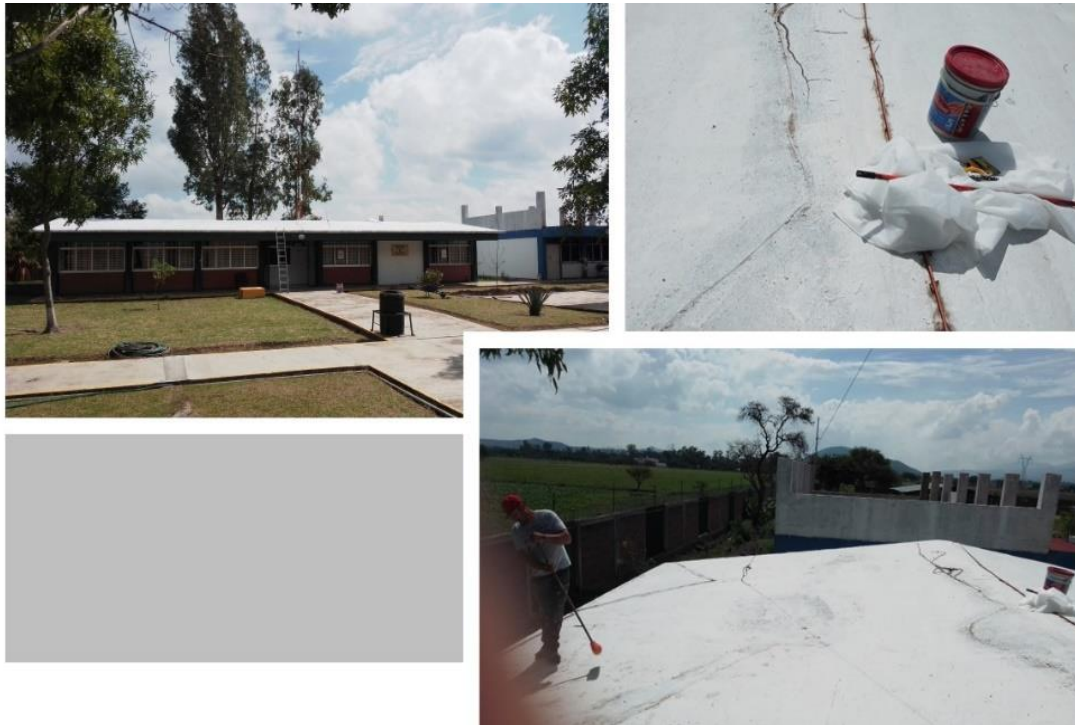
Ilustración 31. Mantenimiento a filtración de agua en techo.
