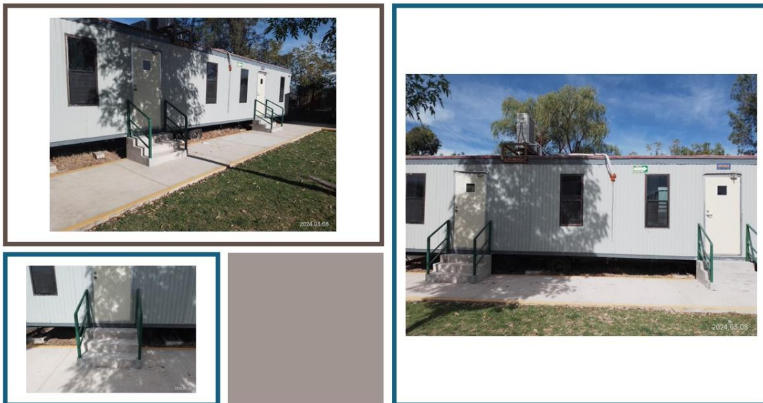
Ilustración 38. Instalación de pasamanos y escalones Unidad Móvil.
