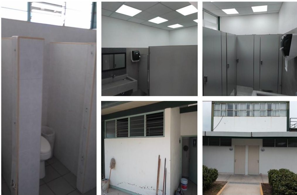
Ilustración 36. Mantenimiento Baños de la Planta Piloto.
