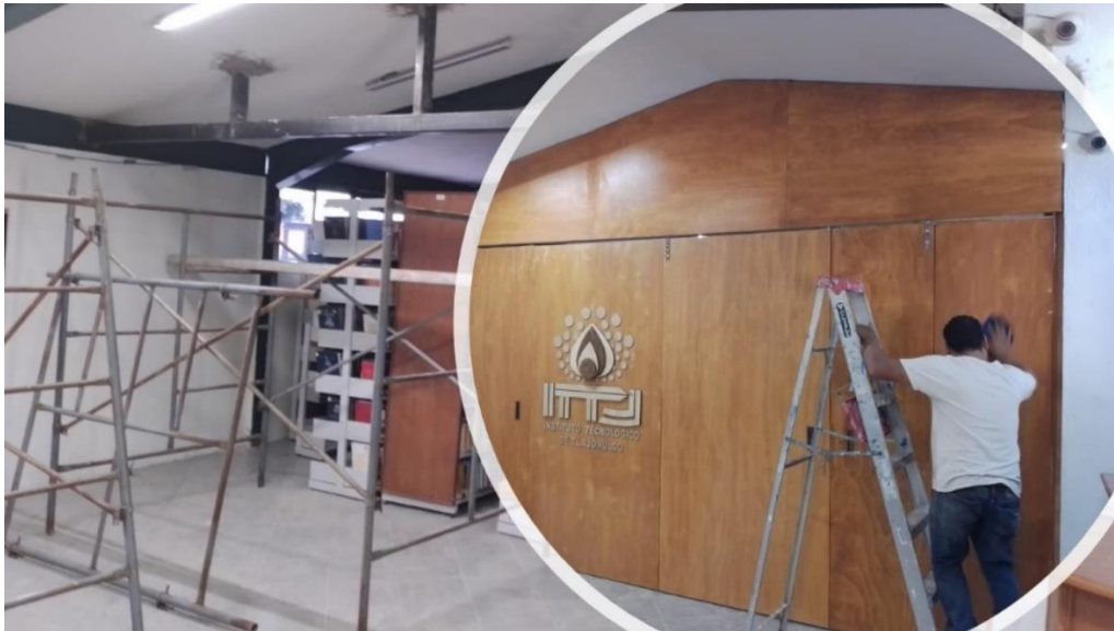
Ilustración 35. Colocación de panel de madera móvil en Centro de Información.
