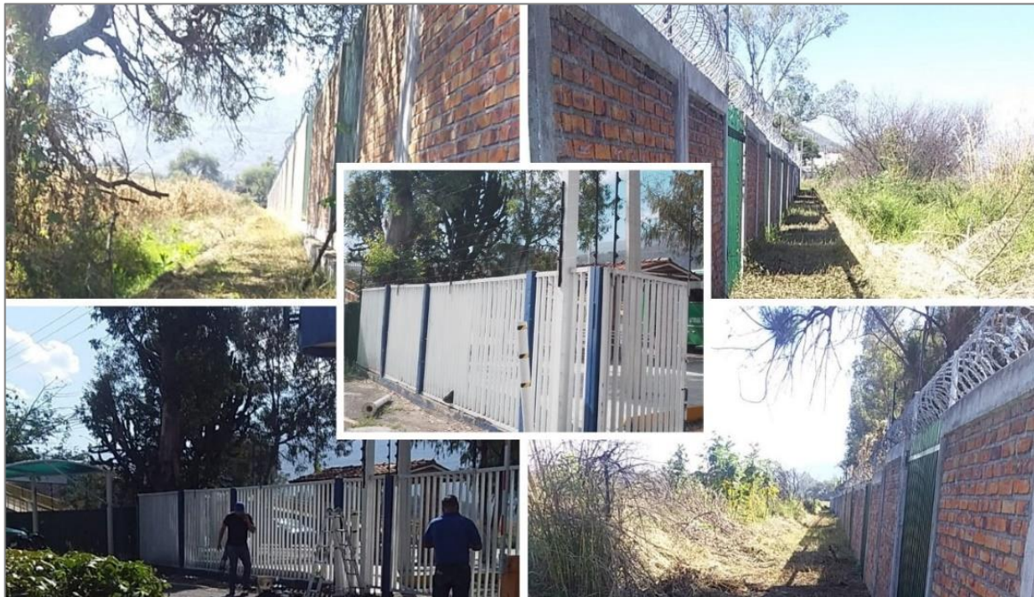
Ilustración 30. Mantenimiento Cerca Eléctrica.
